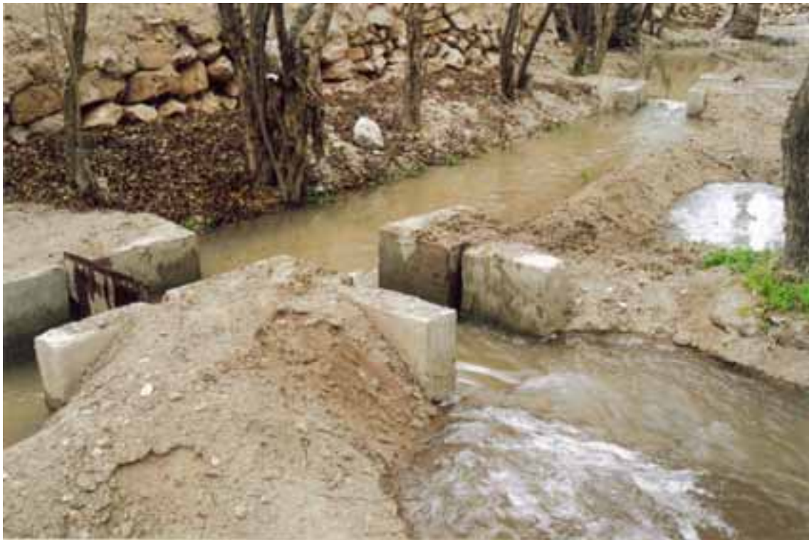
Photo 6 – Arrivée par canal de l'eau d'irrigation dans la première planche après ouverture de la vanne. Cliché D. Benbabaali 2002.
