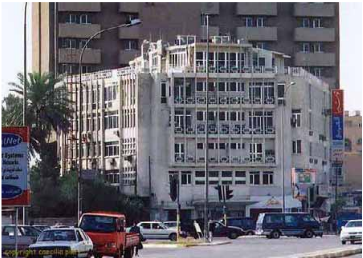
ill.21, 22, 23. Immeubles-îlots des années 50 : Wathiq Square, quartier Battaween, Masbah Square. © C. Pieri
